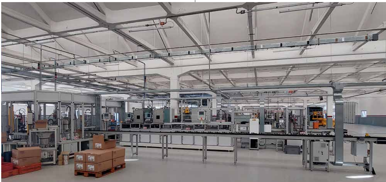
Il nuovo stabilimento a Montecchio (in allestimento) e linea AVAS
